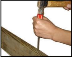
第一步：先将需要安装HD20的木板的一侧打孔，孔高距底侧20mm。
