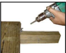
第四步：使用电钻在HD20的钉孔内预先钻孔。
