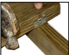
第五步：放入NAS3170，并用铁锤固定，在钉帽靠近钉孔时，使用支撑棒防止锤坏铁件。
