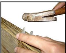
第三步：使用铁锤的侧边将HD20轻锤固定。
